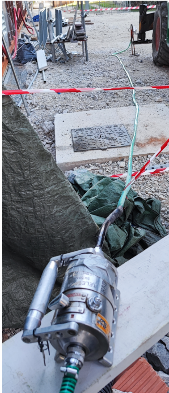
Slika 4.17. Postavljeni daljinski upravljač
