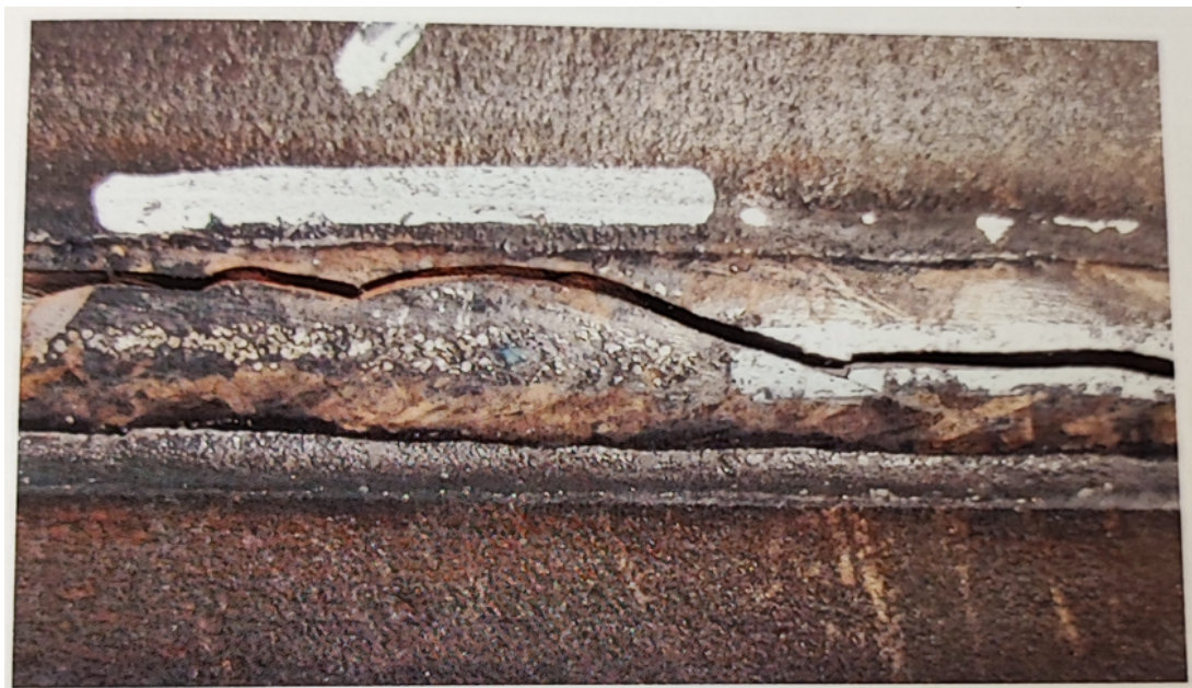
Slika 3.1. Uzdužna pukotina u sučeljenom zavarenom spoju [5]
