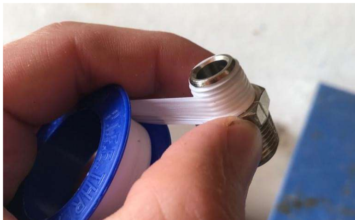
Slika 6.21. Postavljanje teflonske trake na navoj
