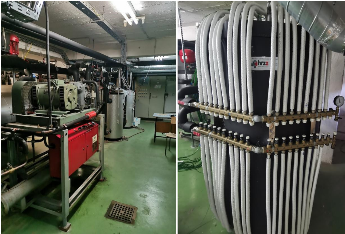
Slika 5.1 Ispitni sustav – dizalica topline i inercijski osjetni spremnici topline (lijevo) i latentni spremnik topline (desno)
