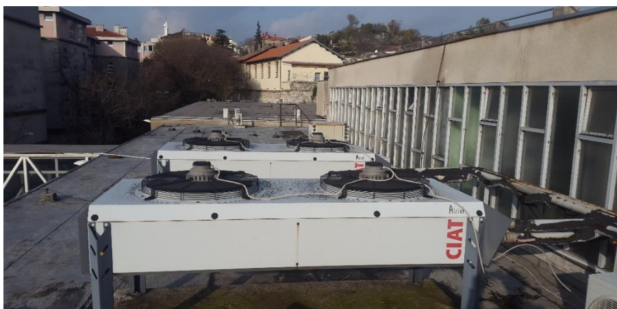
Slika 5.2 Ispitni sustav – suhi hladnjaci
