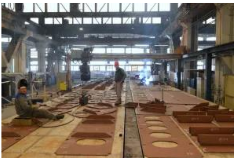
Automatizirana linija za izradu sklopova, Brodosplit (3.7)
