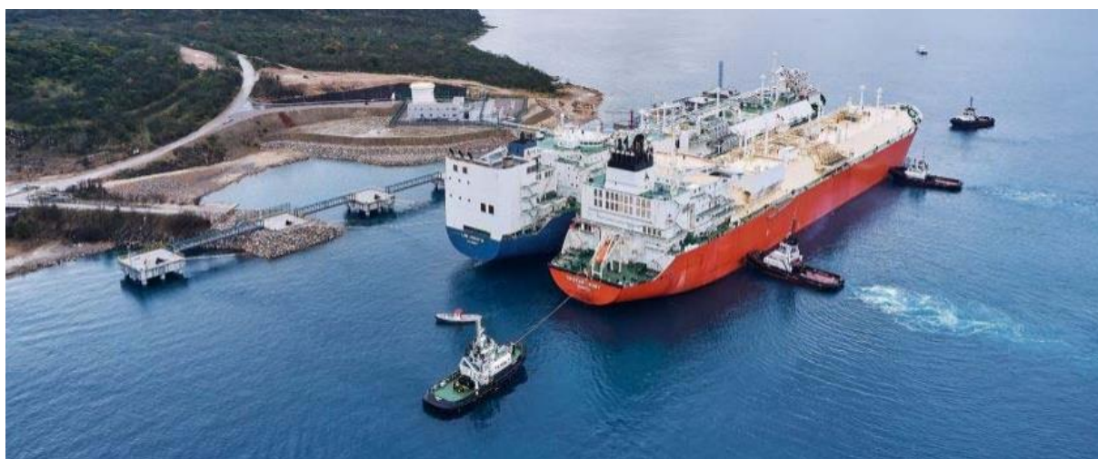
Slika 3.1. LNG terminal KrkOmišalj [5]
