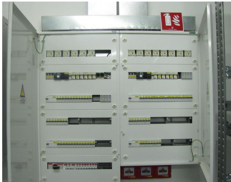
Slika 3.10. ABB industrijski razdjelni ormar [7]
