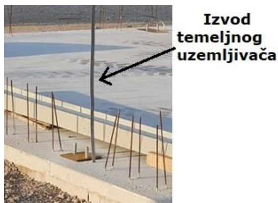
Slika 3.5.2. Izvod temeljnog uzemljivača predviđen crtežom - prilog 8.5
