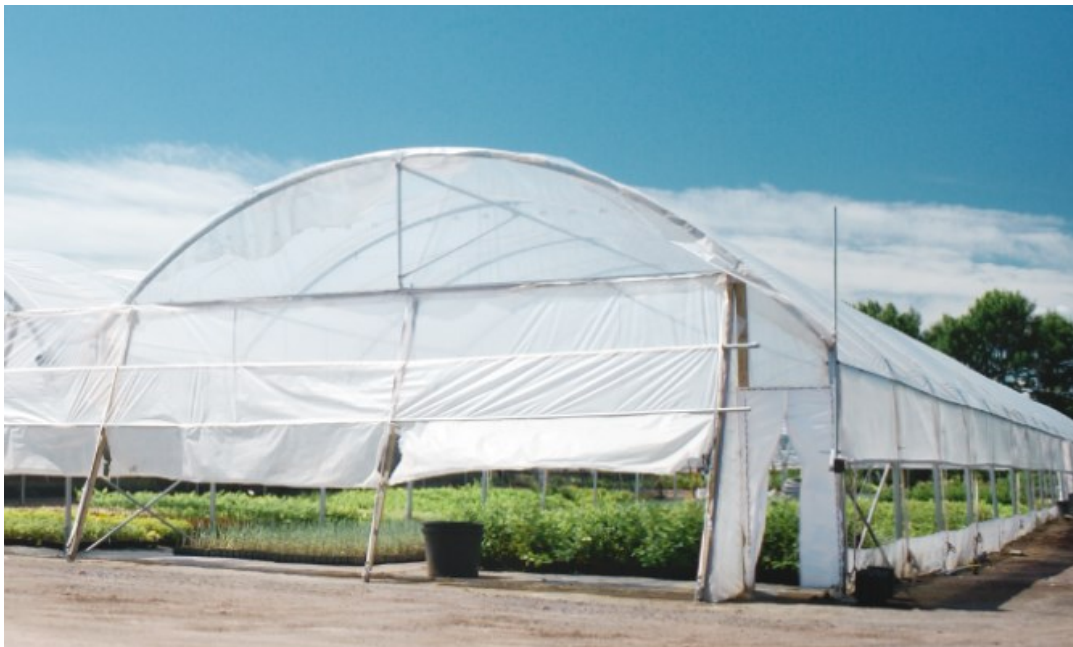
Slika 2.13 Pokrov izrađen od folije [9]
