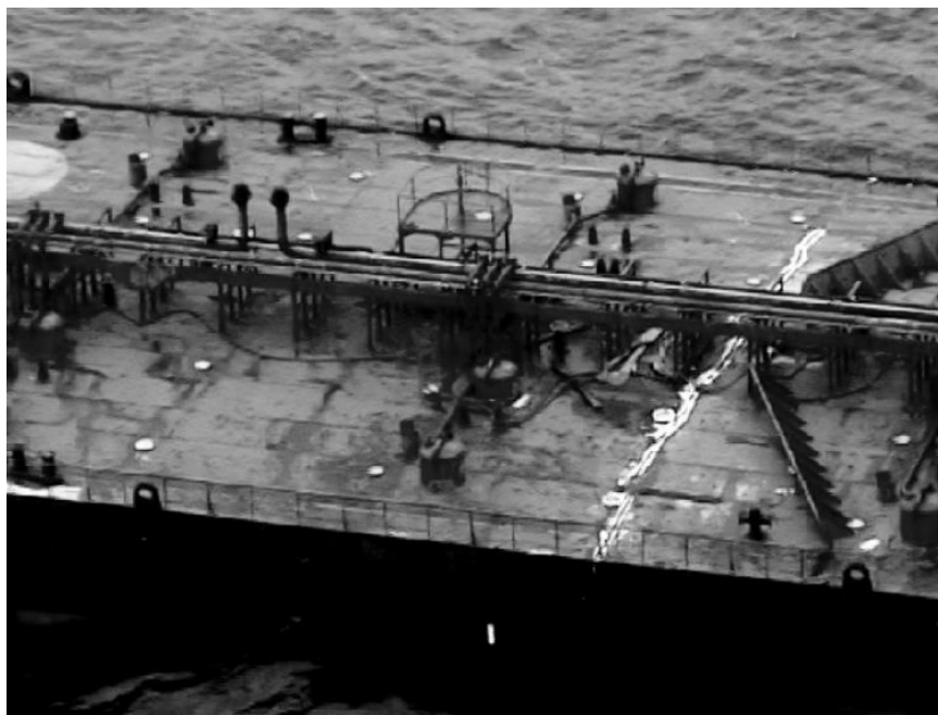
Slika 1.1. Pukotina na tankeru „CASTOR“ [74]
