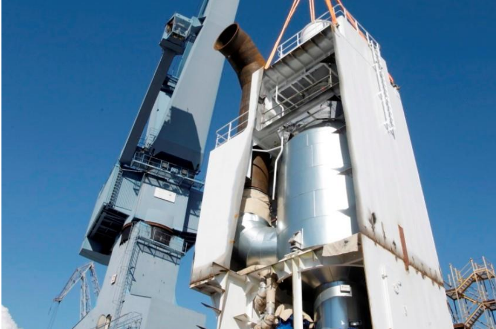
Slika 11.Prikaz scrubber uređaja[16]
