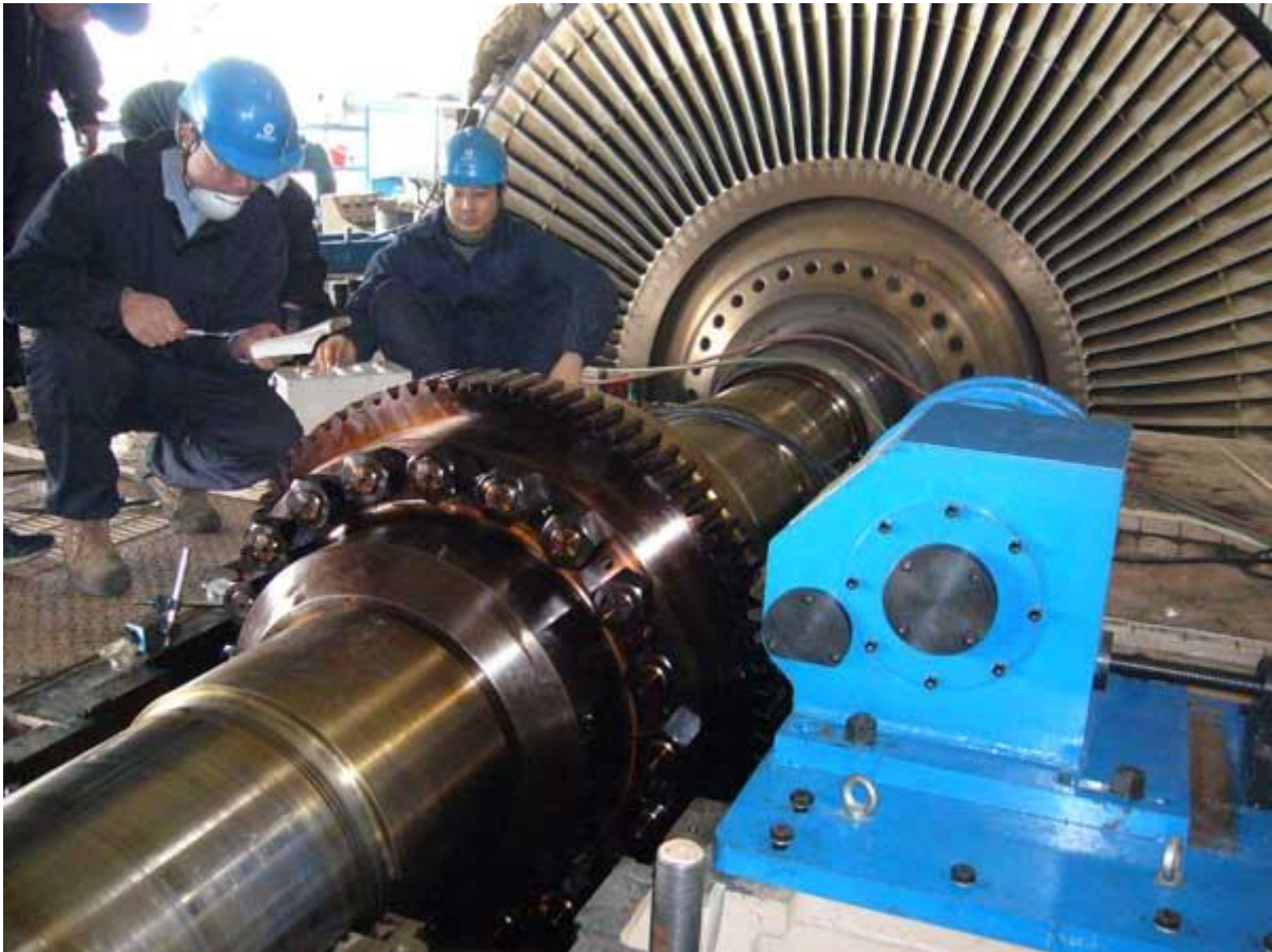
Slika 1.3 Primjer stroja za okretanje parne turbine prilikom remonta [3]
