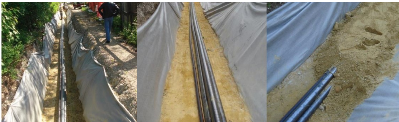
Slika 4.10. Zasipavanje kabela [1]
