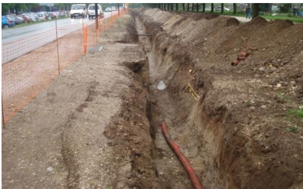
Slika 4.5. Iskopani rov za jednosistemske trasu 110 kV kabela [1]
