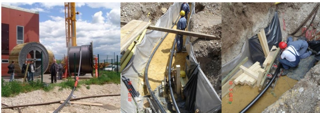
Slika 4.8. Razvlačenje kabela (postavljanje bubnja, razvlačenje u krivini, razvlačenje kroz kabelsku kanalizaciju pri križanju s cestom ) [1]
