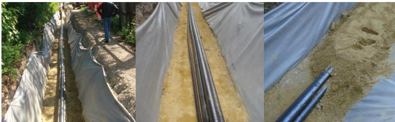
Slika 4.10. Zasipavanje kabela [1]
