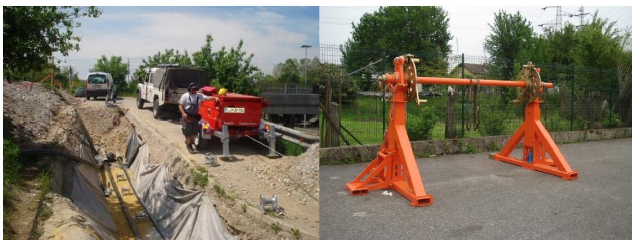
Slika 4.9. Vučno vitlo i postolje za kabelski bubanj[1]
