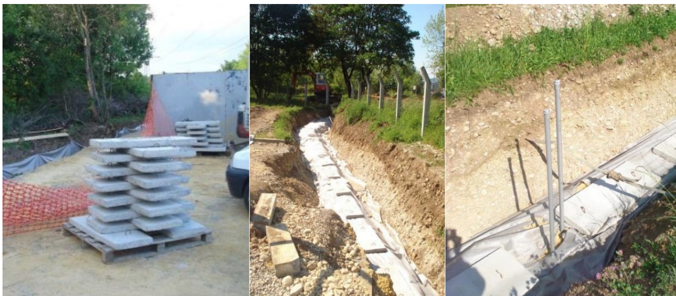
Slika 4.11. Betonske zaštitne ploče i mjerno mjesto [1]
