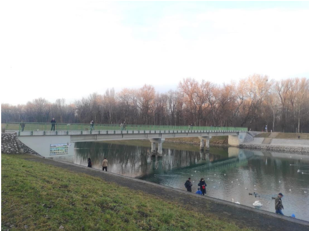
Slika 4.2: Most na kojem je obavljeno mjerenje radarom
