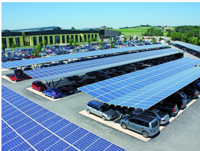
Slika 3.10. Primjena solarnih panela
