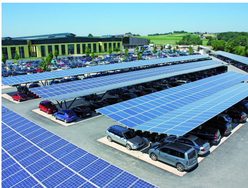
Slika 3.10. Primjena solarnih panela
