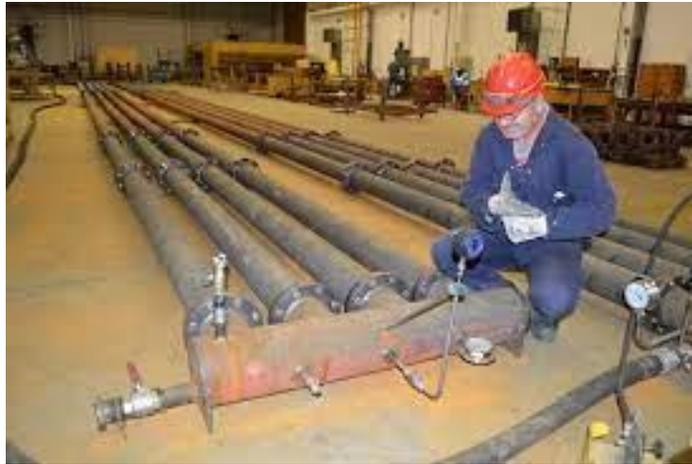
*Slika 22. Princip tlačenja cjevovoda u radioni*
