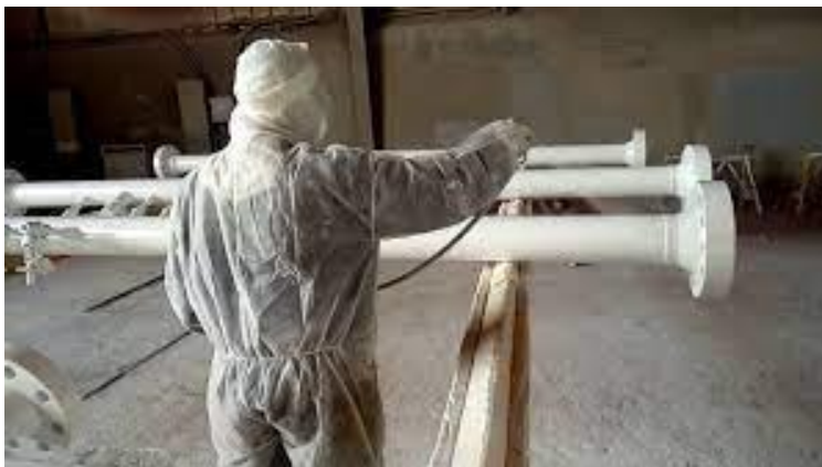
Slika 25. Bojanje cijevi u KZ hali
