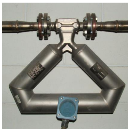
Slika 2.6. Coriolisov protokomjer [2]
