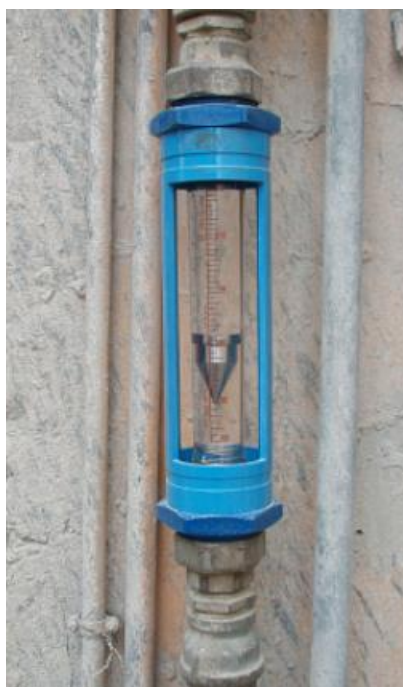
Slika 2.3. Rotametar [2]
