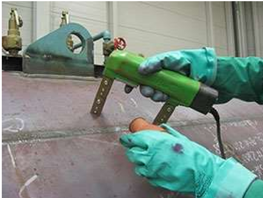
Slika 3.12. Ispitivanje zavarenog spoja magnetskim jarmom [16]
