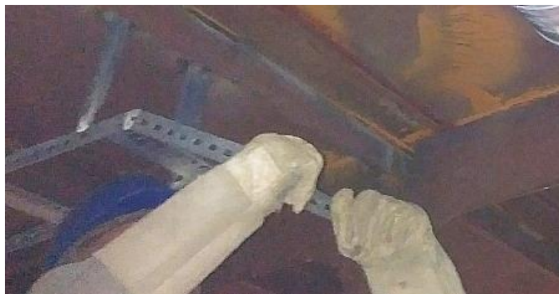
Figure 4 bending of cable tray for changing height Slika 4 Savijanje zbog promjene visine trase
