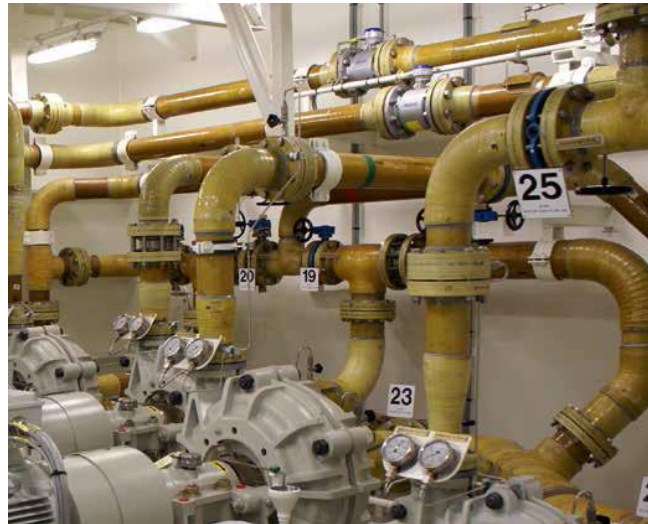
Slika 5. Prikazuje uporabu cjevovoda izrađenih polimera (smole) ojačanih staklenim vlaknima te se na istoj mogu vidjeti tlačni i usisni cjevovodi sisaljki morske vode na putničkom brodu
