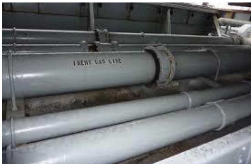
Slika 7. Plastična cijev za inertni plin [10]
