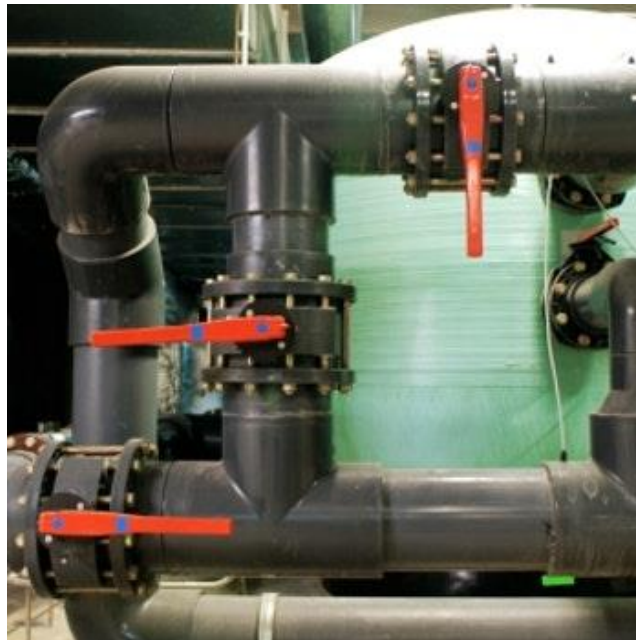
Slika 6. ABS cijevi i prirubnice [4]
