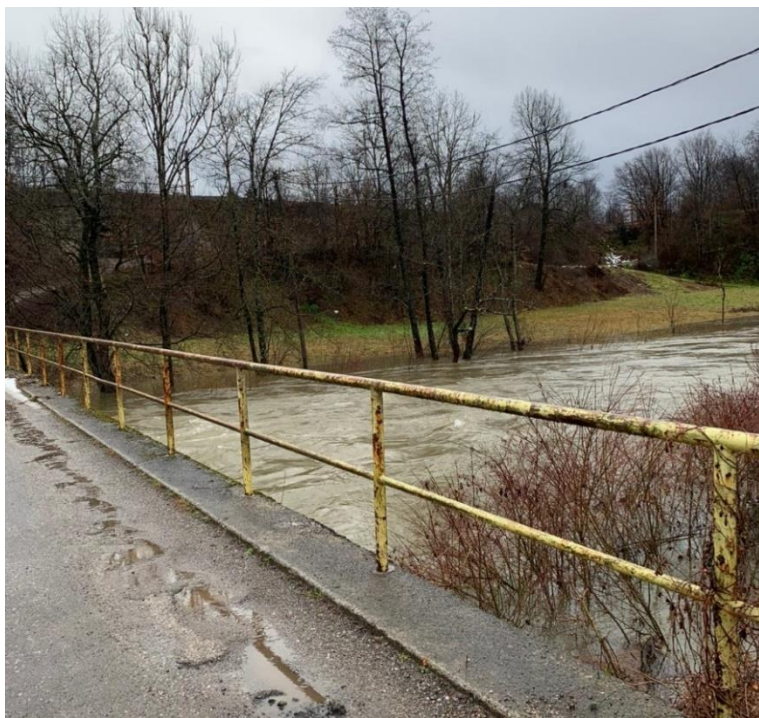
Slika 4.3 Most Pont sur la Dobra
