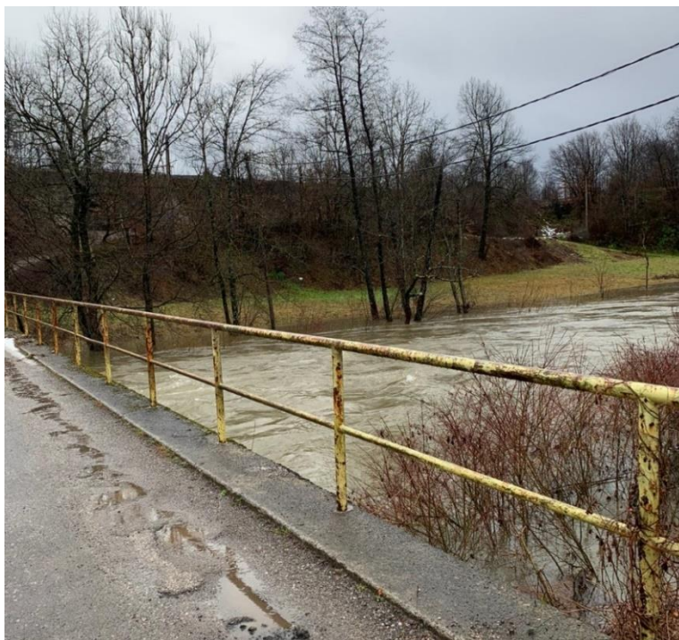
Slika 4.3 Most Pont sur la Dobra
