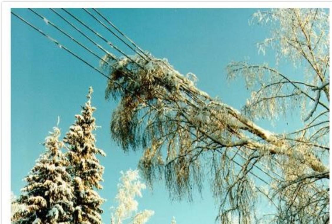
*Slika 3.2.1. Vod s poluizoliranim vodičima s srušenom granom na vodiče dok je pod naponom [6]*
