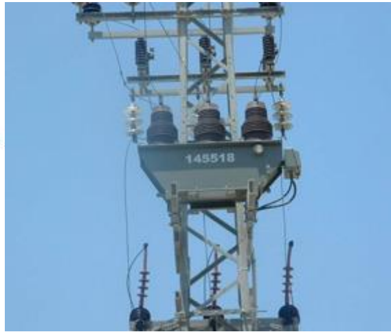
Slika 5.1. Prikaz kombiniranog mjernog transformatora VAH
