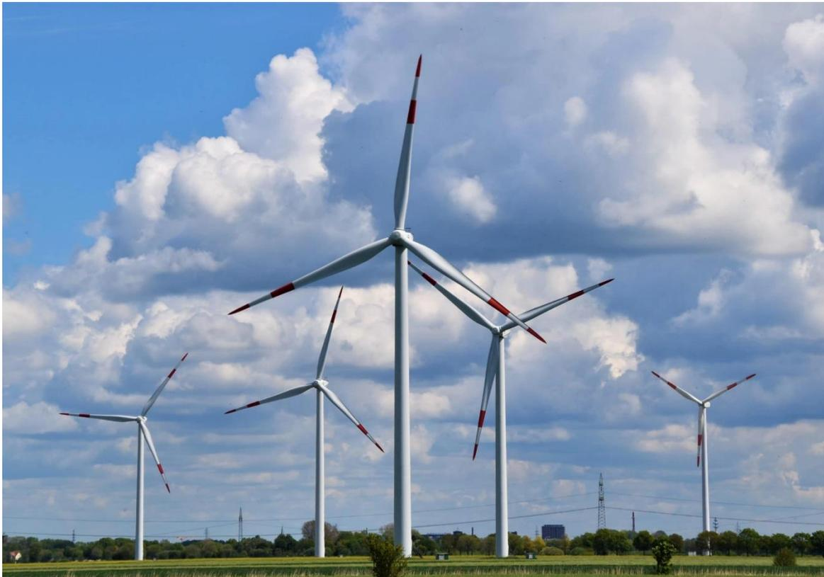
Slika 2.3. Horizontalni tip vjetroturbine
