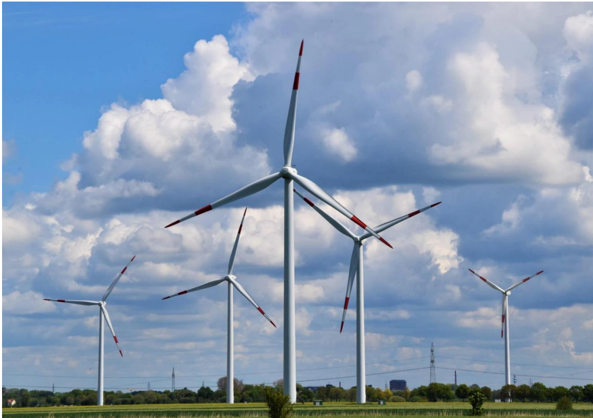
Slika 2.3. Horizontalni tip vjetroturbine
