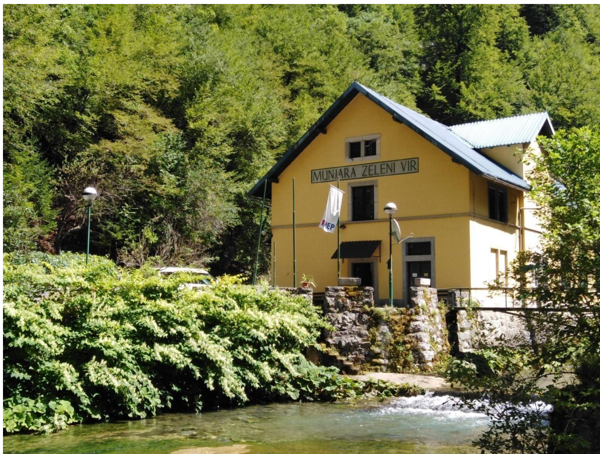
Slika 4.2. Hidroelektrana Zeleni Vir
