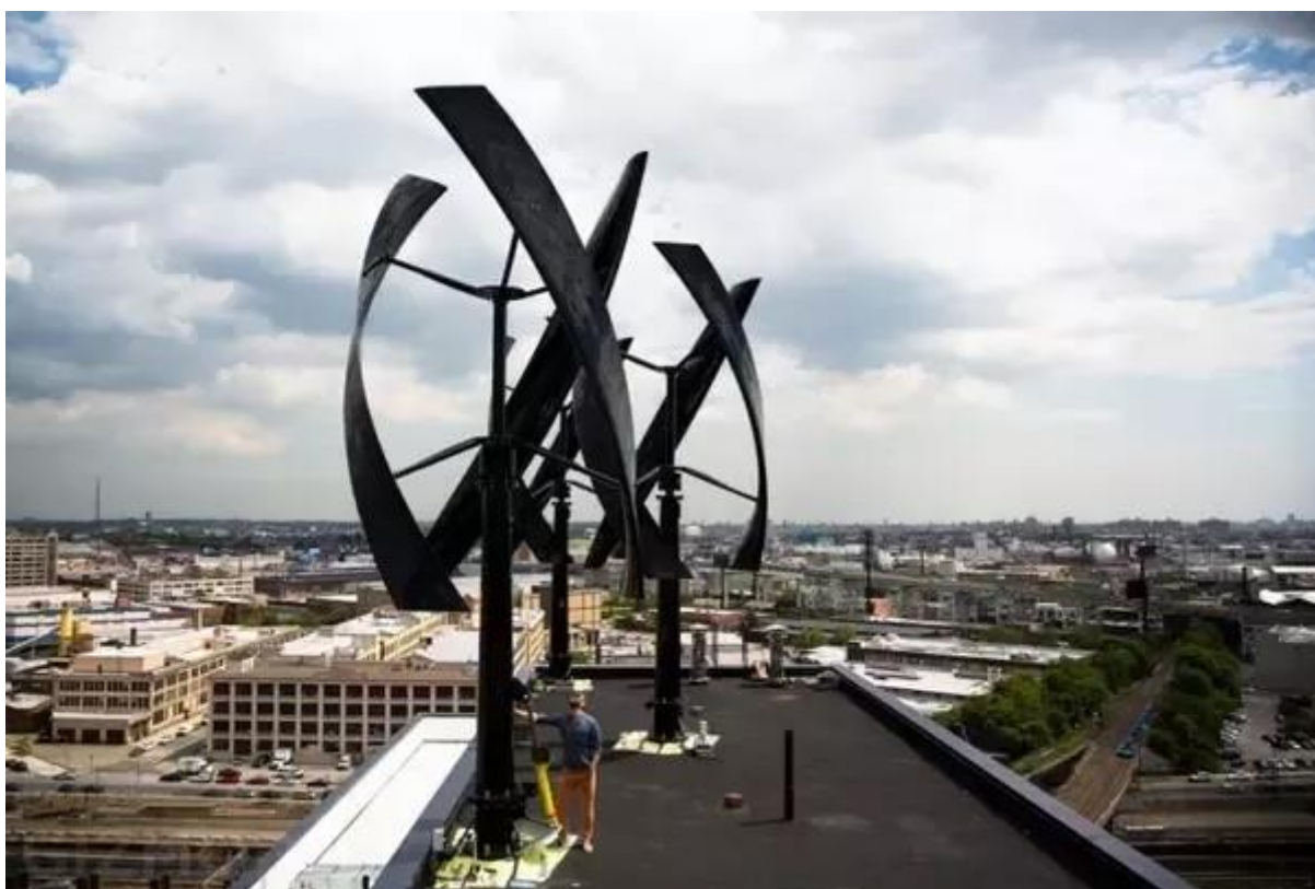
Slika 4.5. Prikaz VAWT krovne vjetroturbine tipa „darrieus“ [30]
