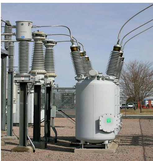
Slika 4.1. Uljni prekidač
