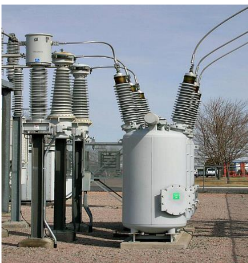
Slika 4.1. Uljni prekidač
