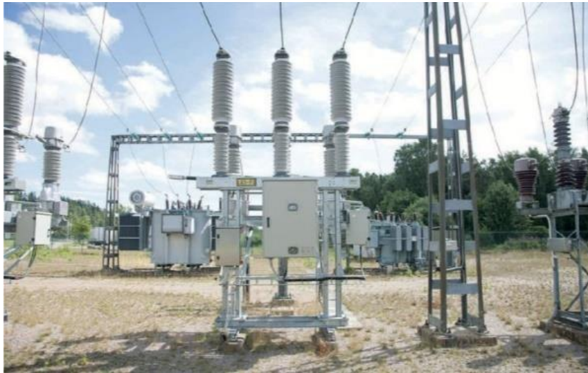
Slika 4.9. EconiQ 145 kV prekidač
