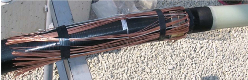
Slika 6.1: Priprema visokonaponskog kabela za spajanje [2]
