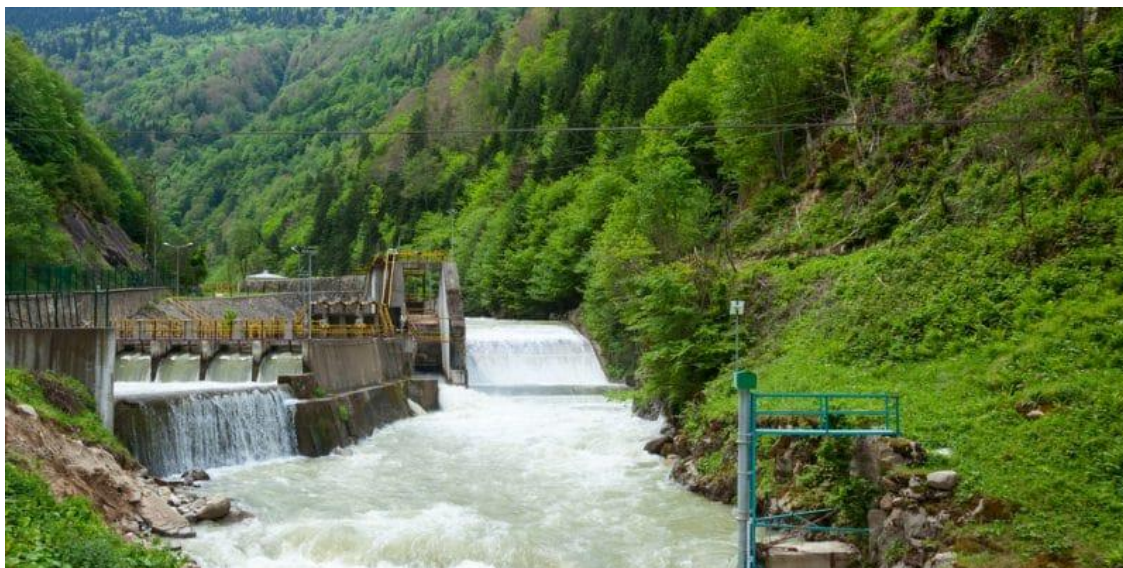
Slika 3.6. Srednja HE na istoku Gane sa snagom od 45 kW [12]
