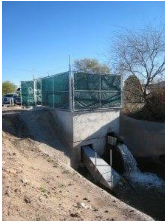
Slika 3.8. Odvodni kanal HE Buckeye, USA [34]
