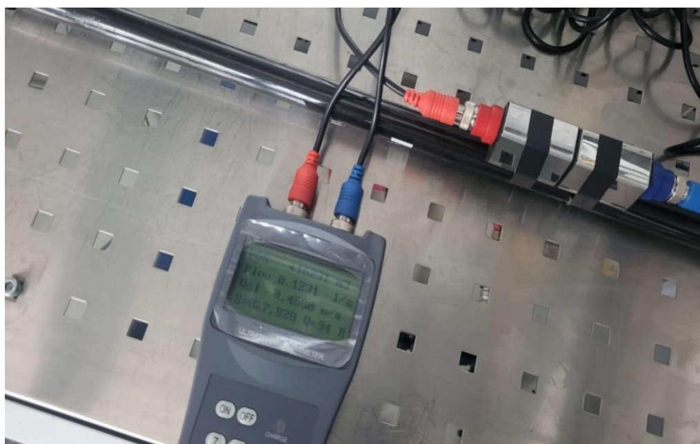
Slika 7.4. Ispravno postavljeni pretvarači na cijev (izvor: autor)
