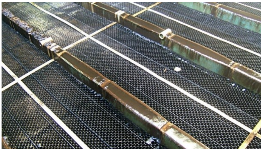
Slika 3.2. Razvodni kanali i ćelije rashladnog tornja [4]
