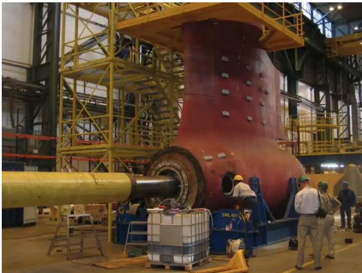
Slika 2.4. Inspekcija i popravci [4]
