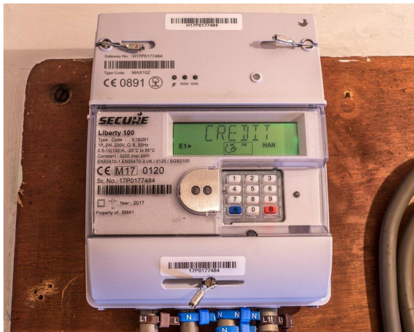
Slika 5.1. Napredno brojilo [11]
