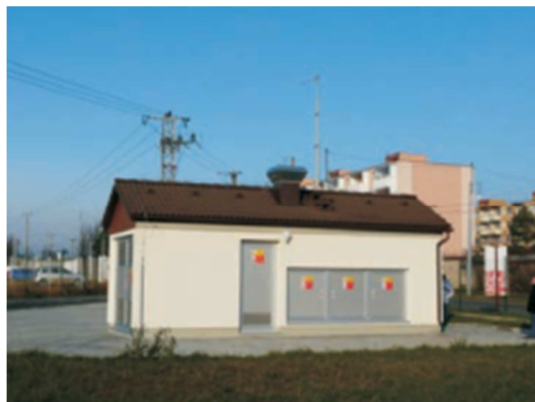
Slika 3.11. Trafostanica za trolejbusnu kontaktnu mrežu, Brno, Češka. [10]
