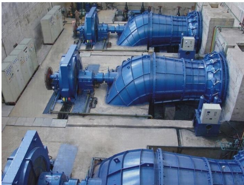
Slika 4.4. Cijevna turbina [8]
