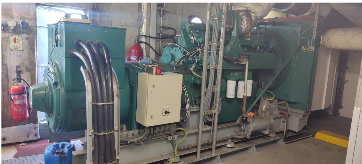
Slika 10.2. Generator za nuždu MT Marko Polo
