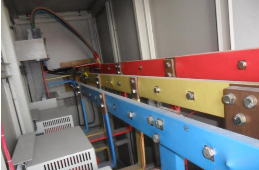
Slika 7.1. Sabirnice u ormaru [30]
