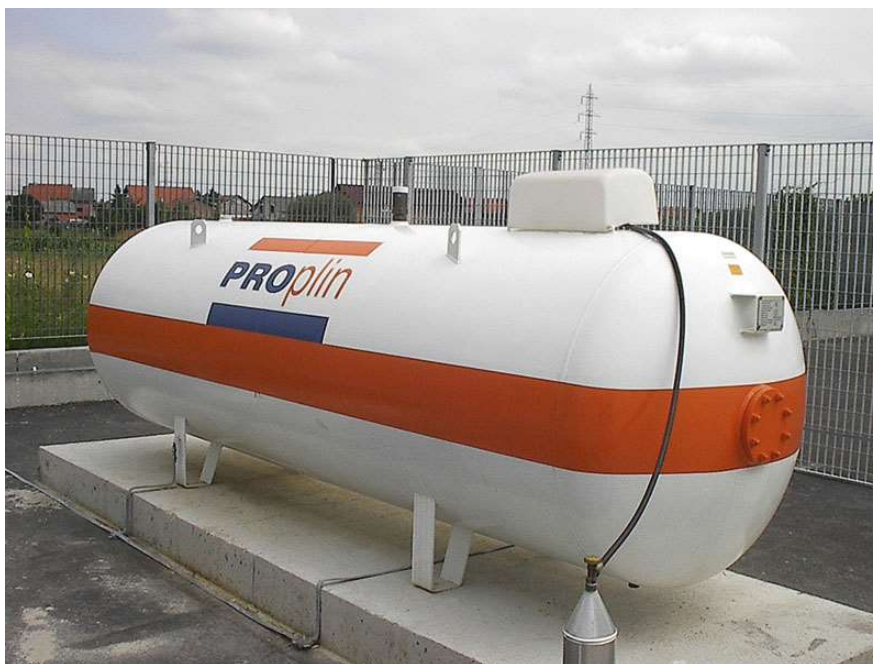
Slika 3.2. Mali nadzemni spremnik UNP-a
