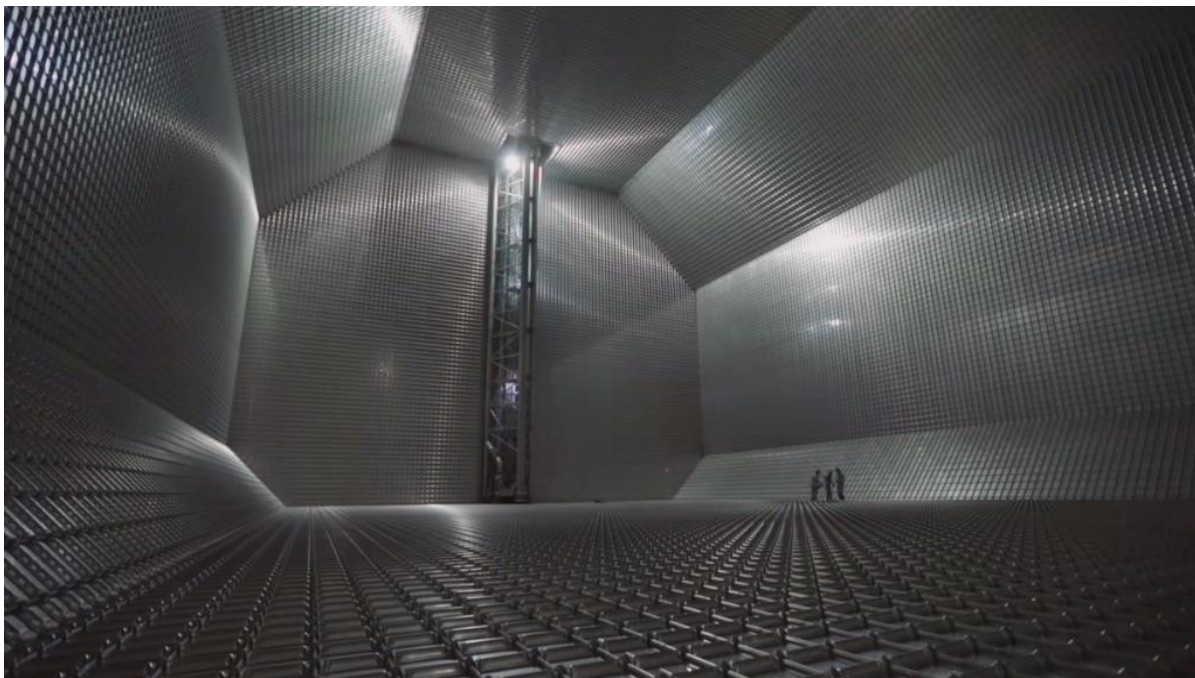
Slika 3.4 Unutrašnjost spremnika tankera [8]
