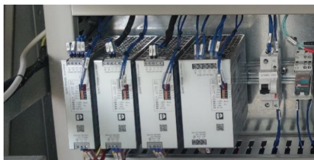
Slika 2.6. Napajanja 24 V
