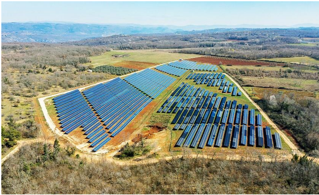
Slika 2.5. Neintegrirana sunčana elektrana [7]
