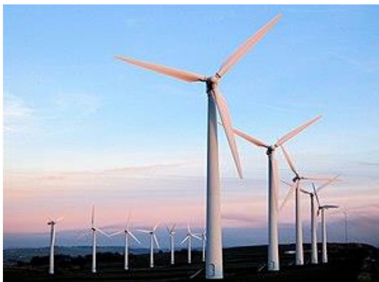
Slika 2.4. Vjetroelektrane Royd Moor u Ujedinjenom Kraljevstvu [5]
