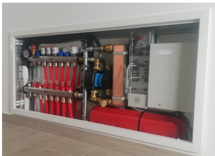
Slika 5.3. Originalni sustav za integraciju dizalice topline
