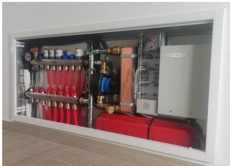
Slika 5.3. Originalni sustav za integraciju dizalice topline
