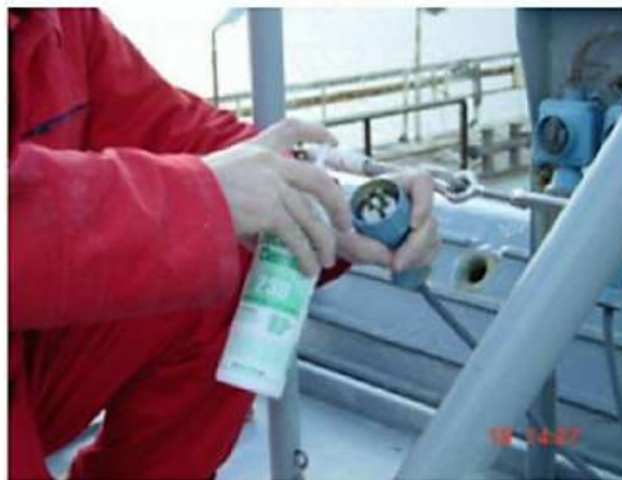
Slika 5.9. Primjena inhibitora kod zaštite električnih kontakata [22]
