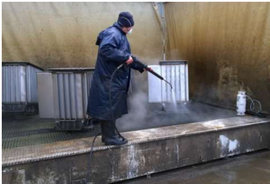
Slika 4.1. Odmašćivanje visokotlačnim prskanjem [8]
