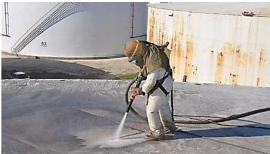
Slika 4.3. Postupak pjeskarenja [13]
