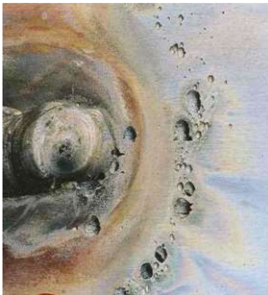
Slika 3.3. Rupičasta korozija metala [9]
